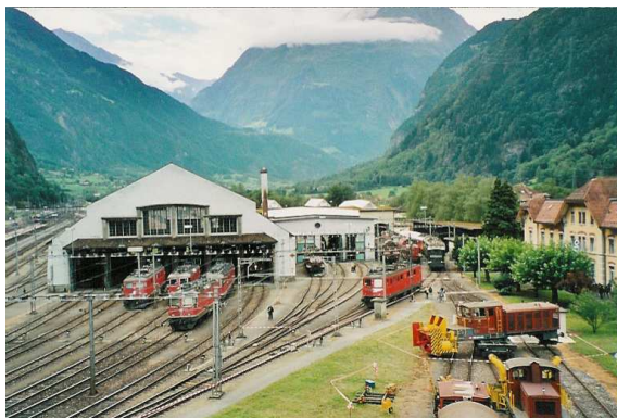
Blick vom Turm auf die Depotanlage
