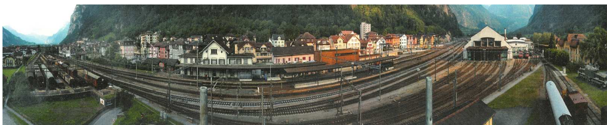
Vom Turm aus sind die Gleiseanlagen von Bahnhof und Depot Erstfeld gut zu überblicken.
